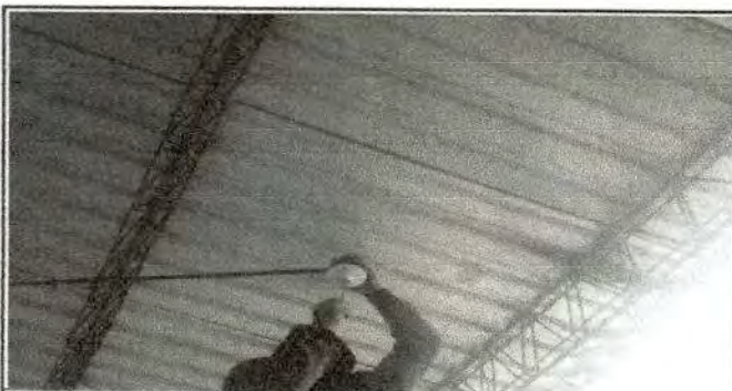
Foto 11: Sustitución de focos ahorradores
