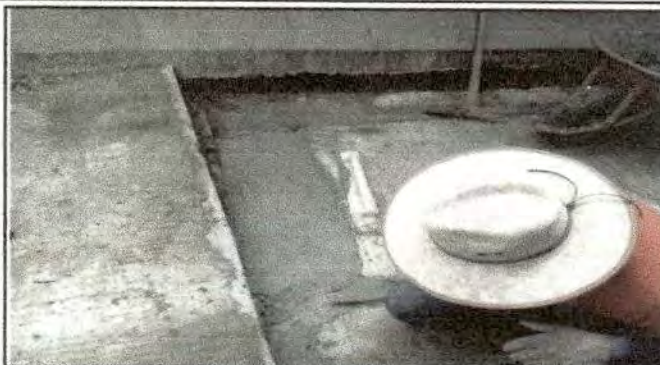
Foto 7: Reparación de banquetas de concreto
