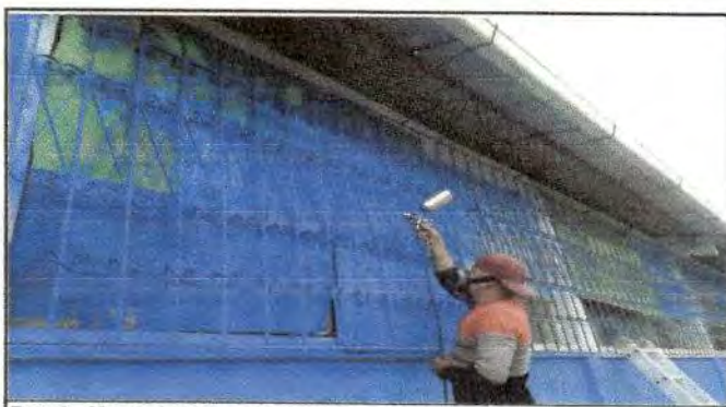
Foto 3: Mantenimiento de balcones
