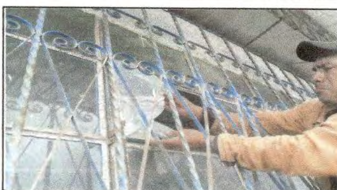
Foto 4: Sustitución de vidrios
