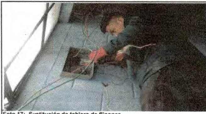
Foto 17: Sustitución de tablero de flipones
