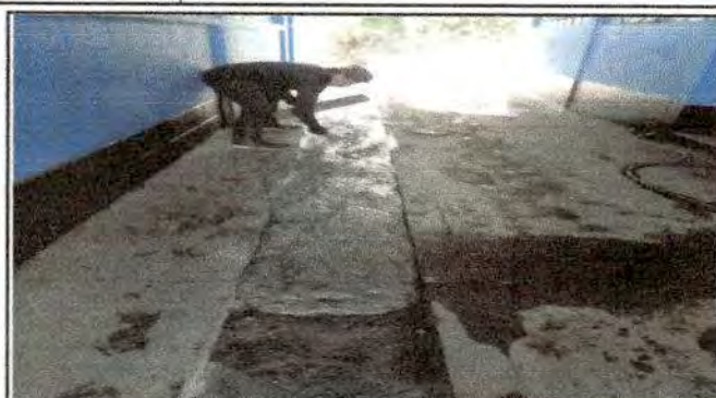
Foto 8: Reparación de cuneta de concreto
