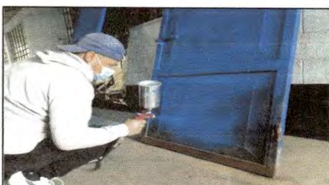
Foto 10: Aplicación de pintura a puerta de metal
