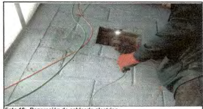
Foto 18: Reparación de cableado eléctrico
