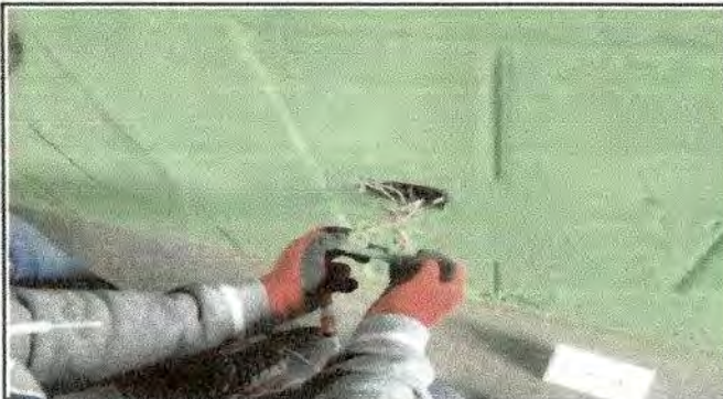
Foto 15: Sustitución de tomacorrientes dobles
