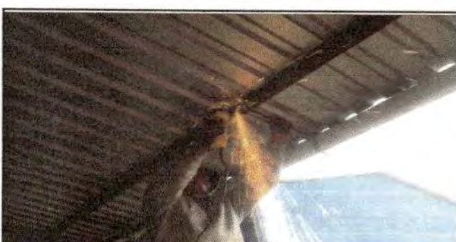
Foto 6: Sustitución de pescante de metal para canal
