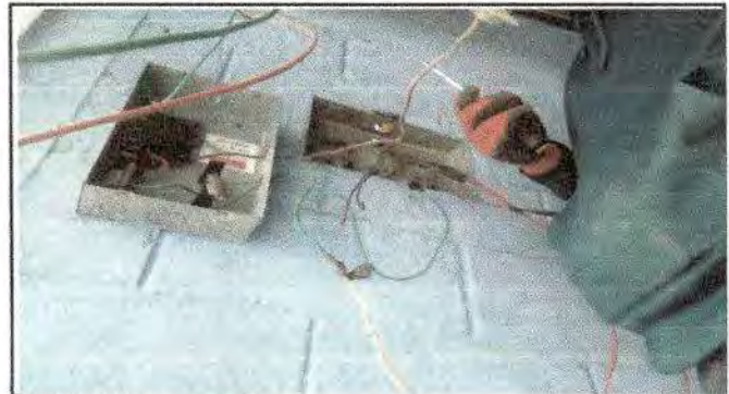
Foto 16: Sustitución de flipones
