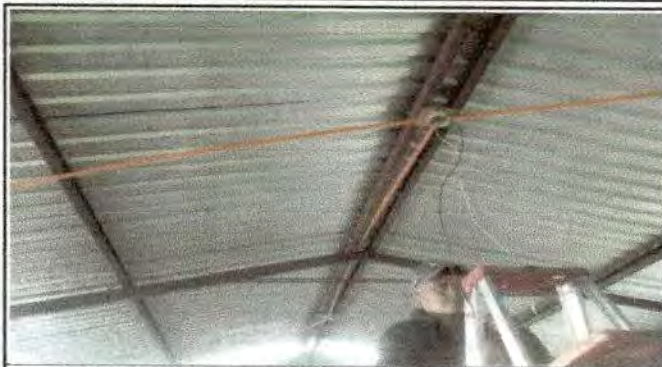
Foto 19: Sustitución de ducto eléctrico
