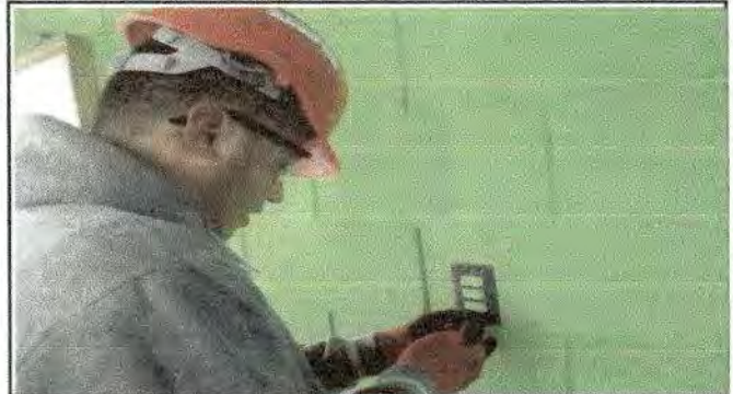
Foto 14: Sustitución de interruptores triples
