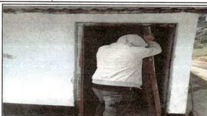
Foto 2: Sustitución de puerta de madera a metal
